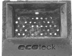
Brændskål, som skal rengøres med huller tilstoppet af aske
